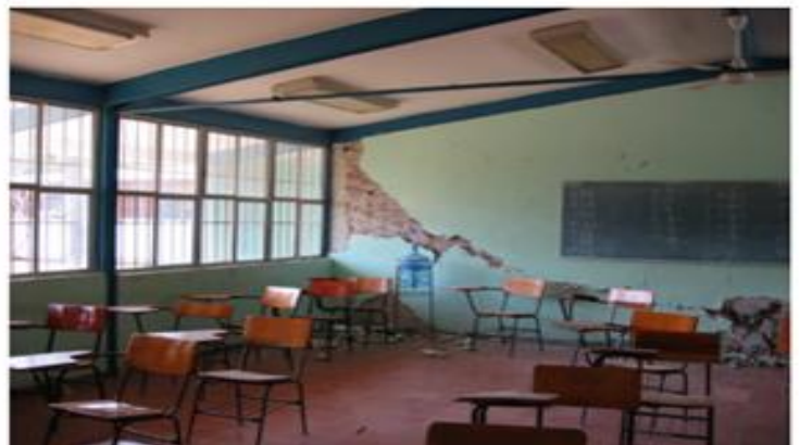
Daños en un muro de una escuela primaria en Ixtlahuacán por un sismo en el año 2003. Extraído del CENAPRED
